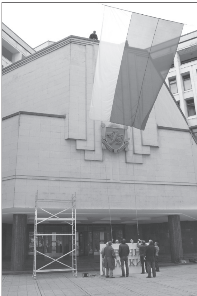
Демонтаж вывесок со старыми наименованиями на здании Госсовета Республики Крым
